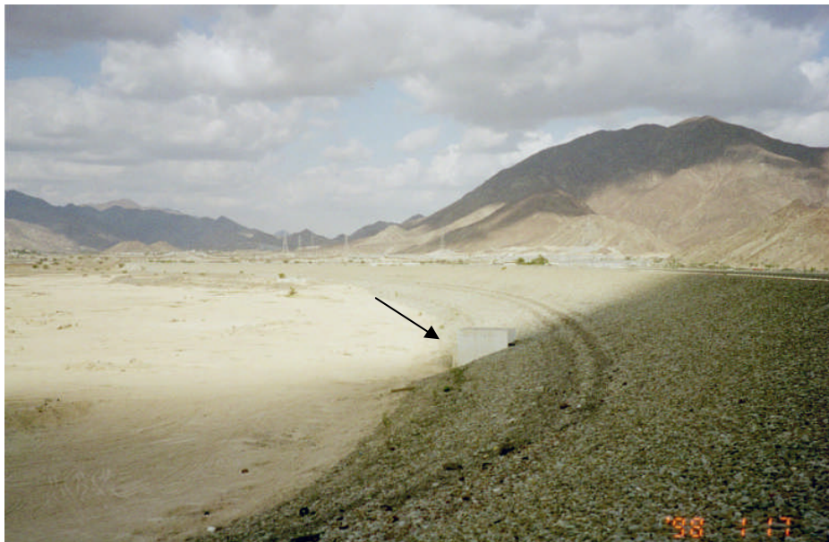
Figure 8.2 Wadi Ham dam outlet.
