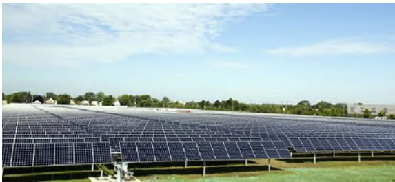
图 6.1. SunPower 光伏电池板安装在 Exelon 城市太阳能项目的单轴跟踪系统中（来源：SolarServer）
