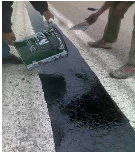
Fig. 6-5. Pouring asphalt slurry
